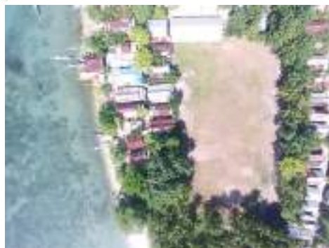
Sisi Barat Pulau
