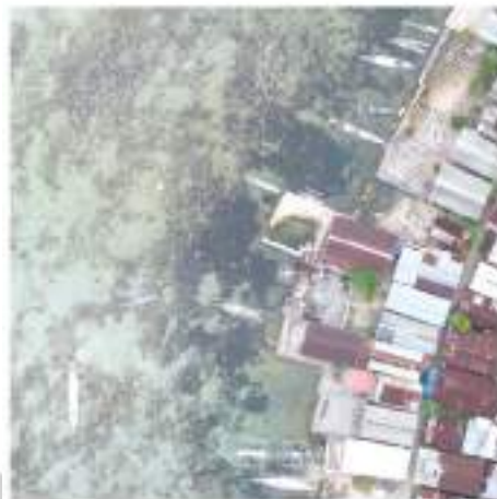
Sisi Barat Pulau
